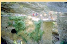
Puente y Molino de las Carihuelas.
