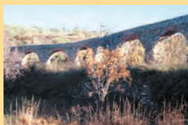
Acueducto de Los Arcos Archivo ADR Alpujarra.
