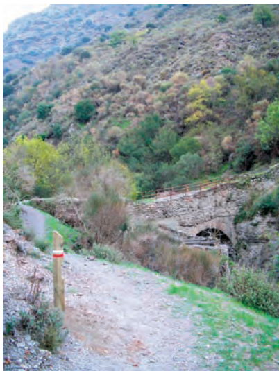
Puente y molino sobre el río Trevélez (Fondales)
