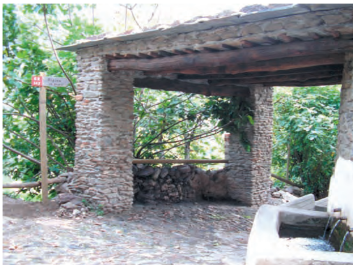
Lavadero de Mecina Fondales.
